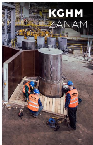
PRZEMYSŁOWE USŁUGI REMONTOWE I MONTAŻOWE
