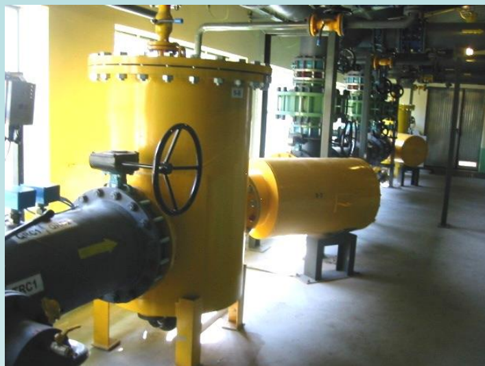
Fot. 7. Stacja odmetanowania - armatura przesyłowa wraz z filtrami.
