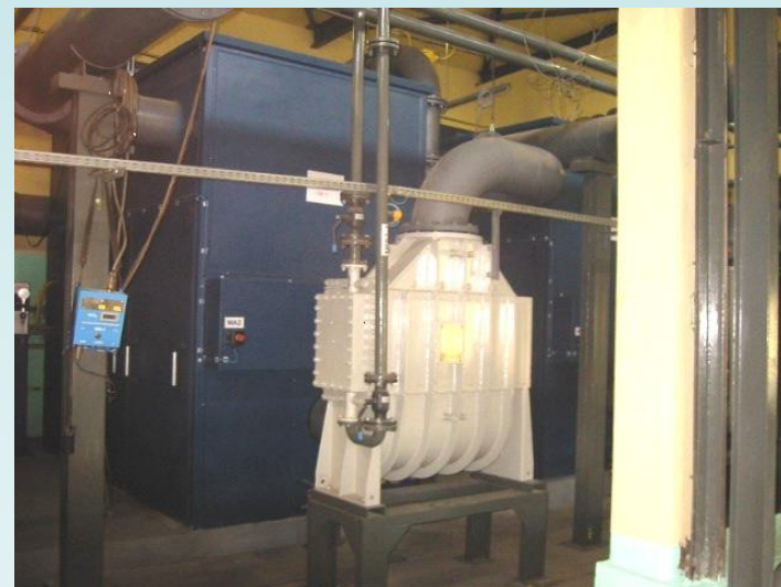
Fot. 8. Stacja odmetanowania - sprężarka w dźwiękoszczelnej obudowie z systemem chłodzącym.
