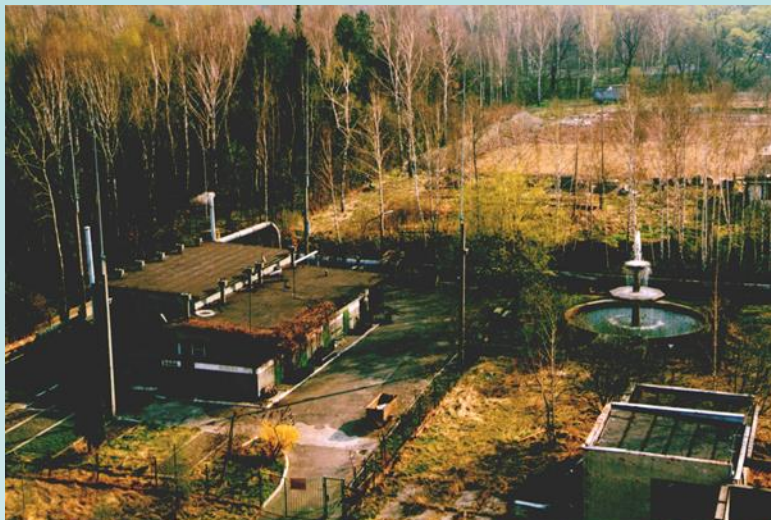
Fot. 9. Budynek stacji odmetanowania przed modernizacją.
