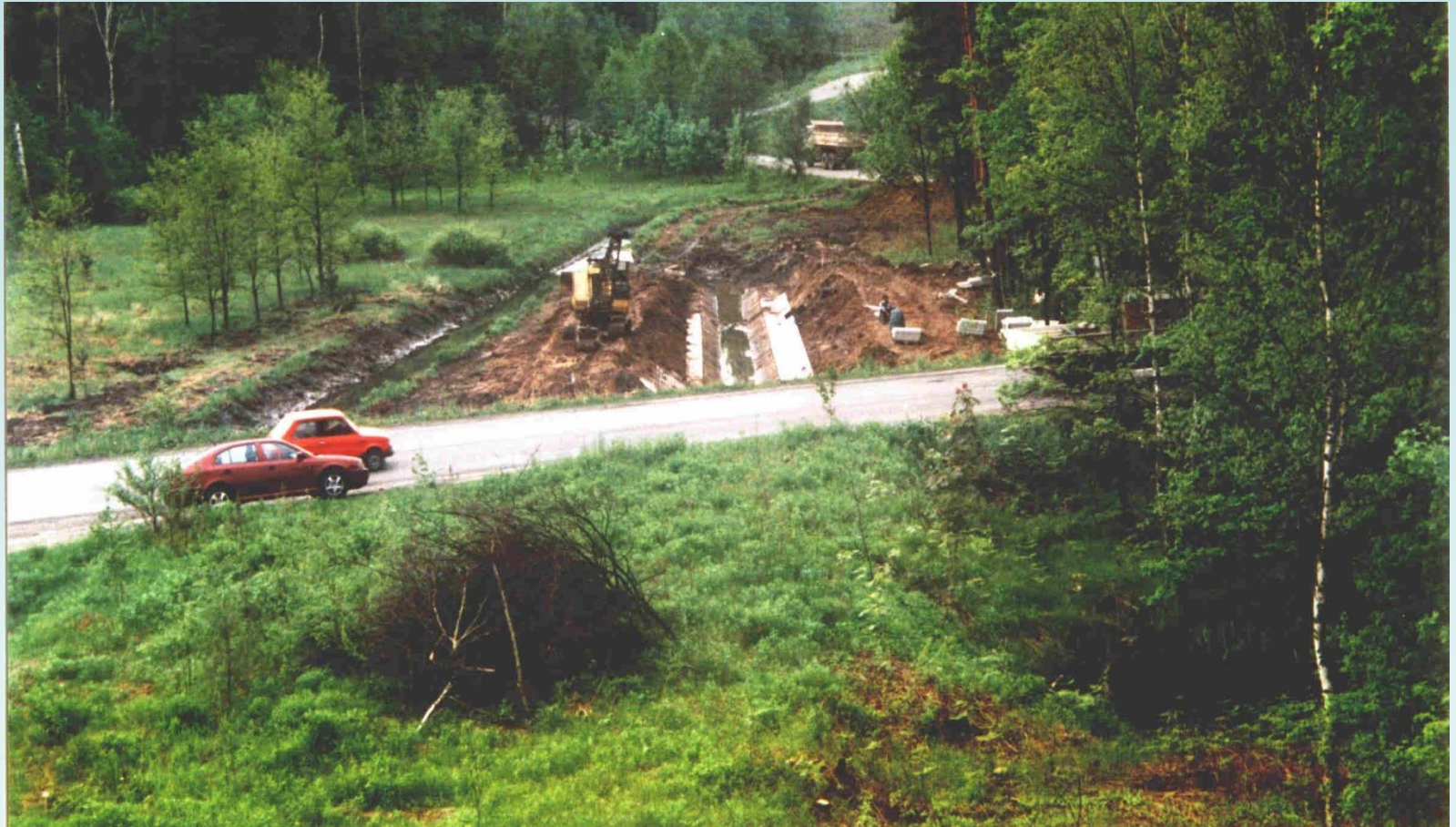
Fot. 25. Rejon przepustu drogowego potoku Bolina Południowa.
