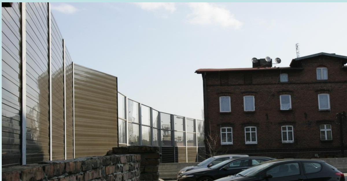
Fot. 13. Ekrany akustyczne – widok od strony budynków mieszkalnych.
