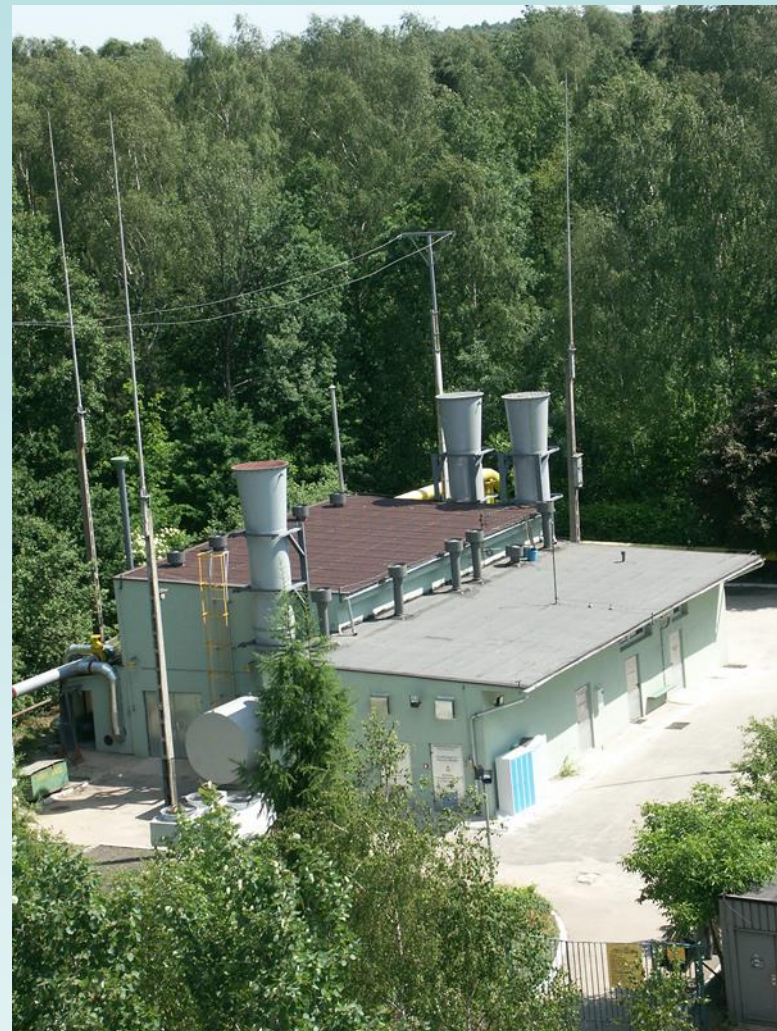
Fot. 10. Budynek stacji odmetanowania po modernizacji.
