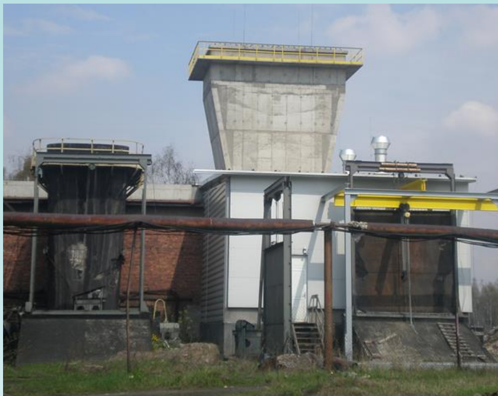
Fot. 12. Stacja wentylatorów głównych.
