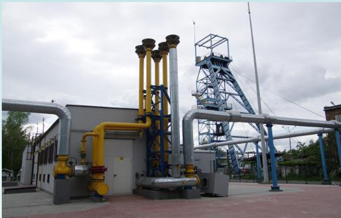
Fot. 11. Stacja odmetanowania - wydmuch z przyłączem gazu.
