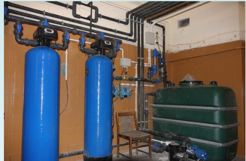
Fot. 4. System uzdatniania i mineralizowania wody.
