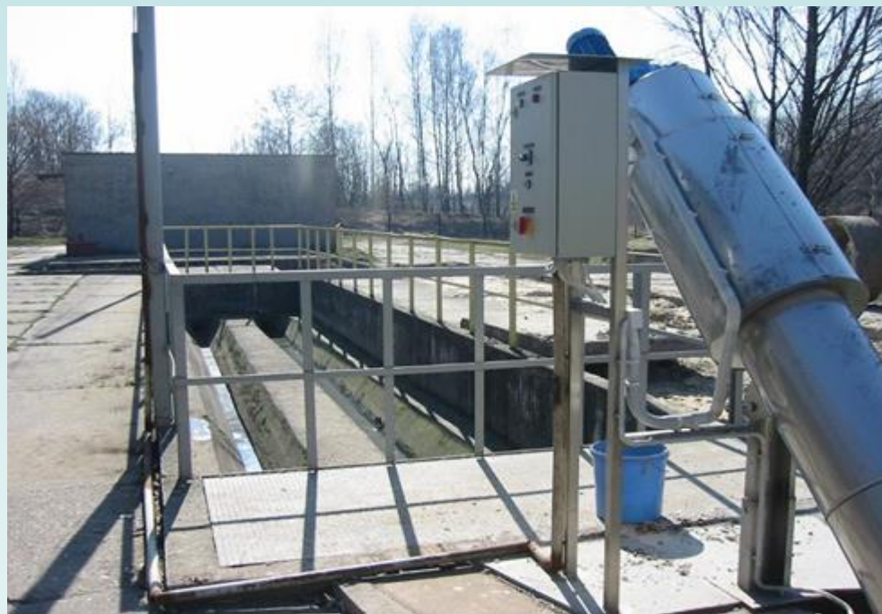
Fot. 2. Przepompownia ścieków – widok na piaskowniki i budynek przepompowni.
