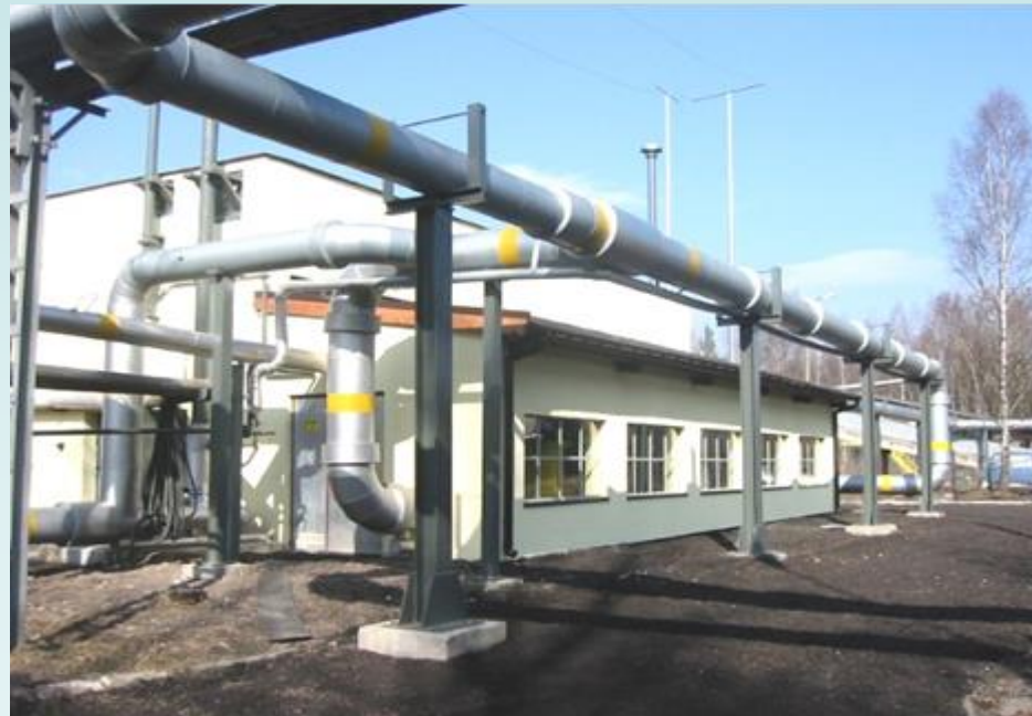
Fot. 6. Stacja odmetanowania - budynek wraz z rurociągami przesyłowymi.
