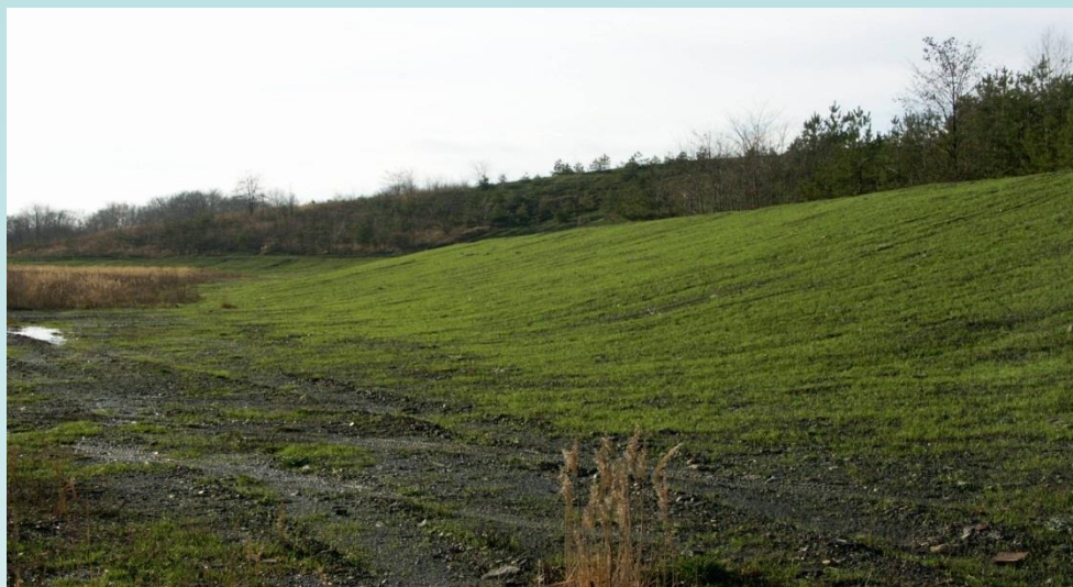
Fot. 20. Fragment jednej ze wschodnich skarp zwałowiska w Katowicach – Murckach, zatrawionej w ramach rekultywacji biologicznej.
