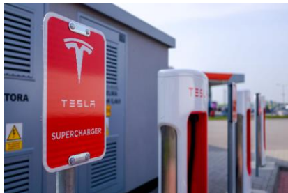
Przyłączenie infrastruktury ładowania do sieci OSD
